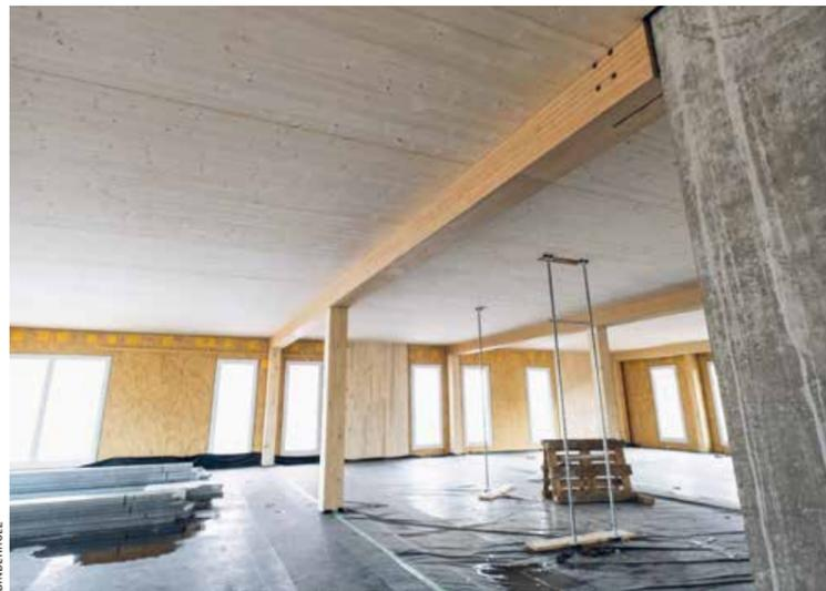
◀ Einige Träger sind in Baubuche gefertigt. So konnte ihre Dimension den Stützen aus Brettschichtholz angepasst werden
