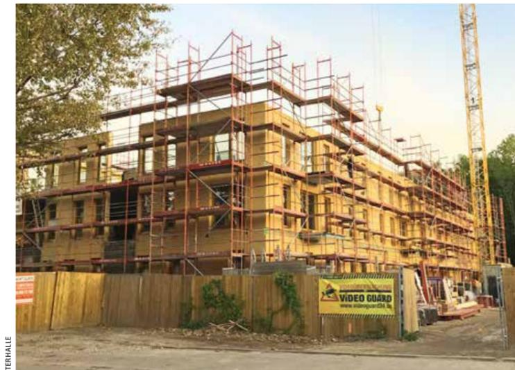
◀ Die schlagregenfeste Hülle ist fertig. Nur die Putzfassade wird erst später hergestellt
