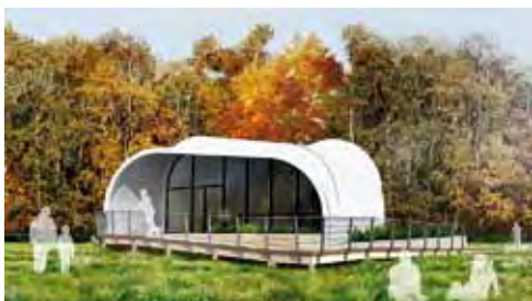
Die textile Hülle des Techstylehauses umschließt ein flexibles „Wohnzelt“ im Passivhausstandard
