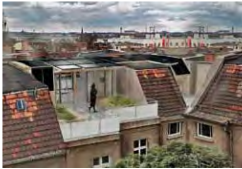
Rooftop ist ein Plusenergie-Modul für die energieeffiziente Nachverdichtung im Ballungsraum
