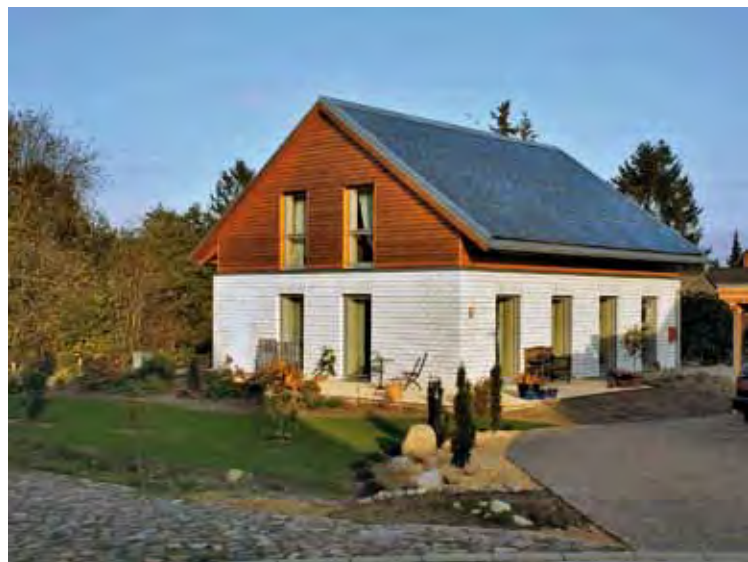
Effizienzhaus Plus in Lüneburg
