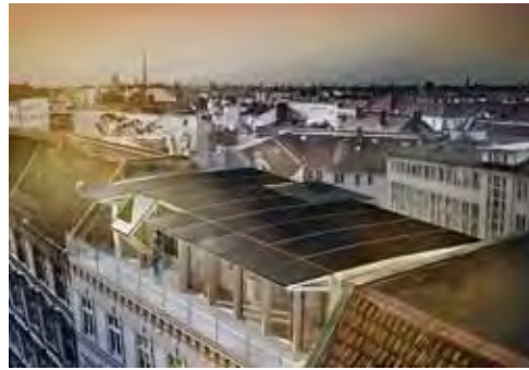
Dach und Fassade werden beim Rooftop-Konzept für die solare Energiegewinnung genutzt
